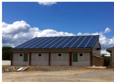
Figure 63 : Bâtiment agricole en Creuse
